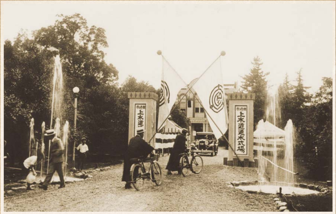
▲昭和8年7月19日、岡崎公園内の岡崎市立図書館前の広場で通水式が行われた。
