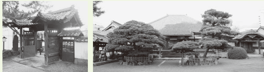
▲左から七面堂、本堂、玄関 概要 本堂／木造平屋建、瓦葺、建築面積184平方メートル、享保19年（1734）建立 七面堂／木造平屋建、瓦葺、建築面積82平方メートル、江戸時代後期建立 玄関／木造平屋建、瓦葺、建築面積67平方メートル、明治31年（1898）建立
