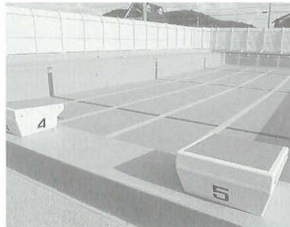
▲六ツ美南部小学校プール
