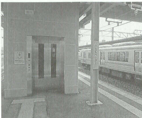
▲上り線ホームに設置されたエレベーター
