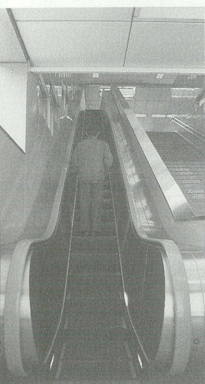
東口に新設されたエスカレーター
