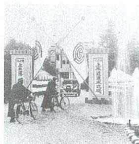
昭和8年7月19日 岡崎公園にての通水式風景
