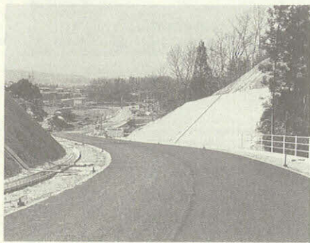
中央総合公園、中央クリーンセンターの進入路となる都市計画道路「大平田口線」
