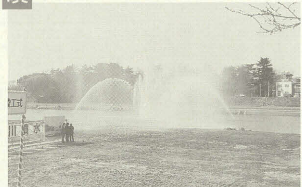
乙川噴水完工式 3月20日 殿橋下流
