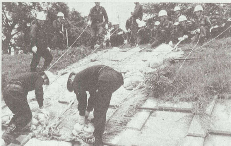
むしろ張り工法
