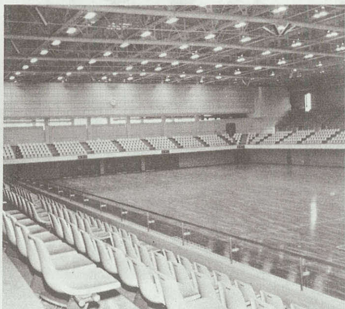
体育館内部 (主競技場)
