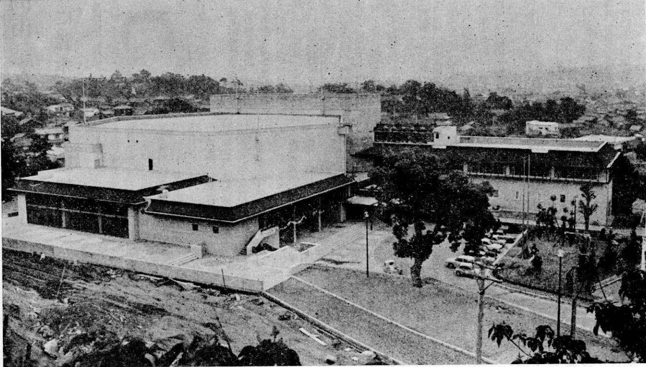
完工した岡崎市民会館の全景
